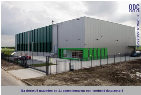
Na slechts 5 maanden en 11 dagen bouwen: een werkend datacenter!
